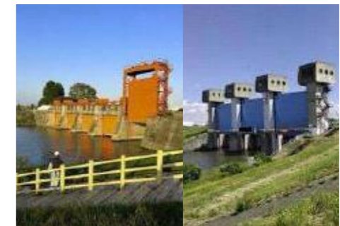
旧岩淵水門(赤水門)・岩淵水門(青水門)
