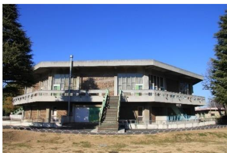
桐ヶ丘体育館
