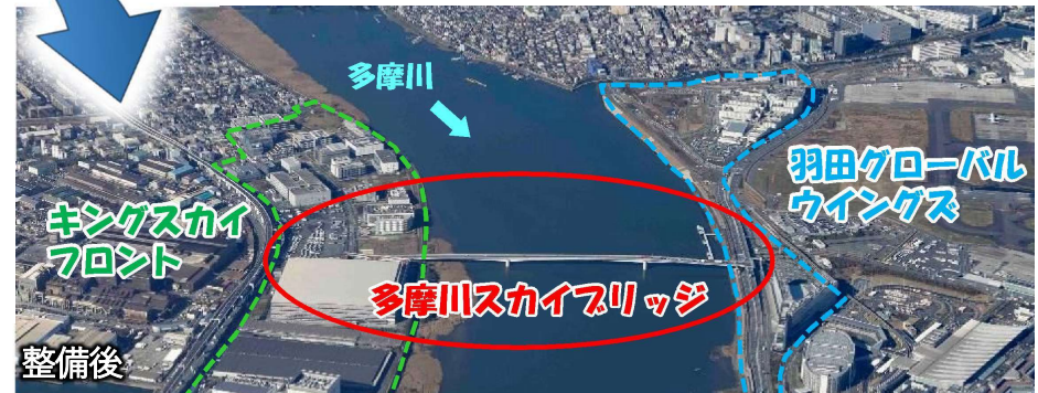
写真は多摩スカイブリッジ 出典：第36回全国街路事業コンクール
