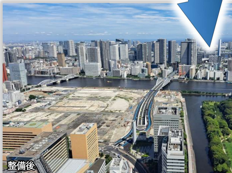
写真は築地・新橋間
