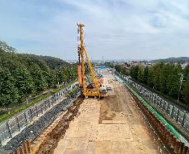
ICT建機による地盤改良工
