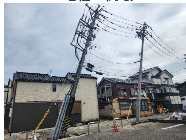
電柱の倒壊
