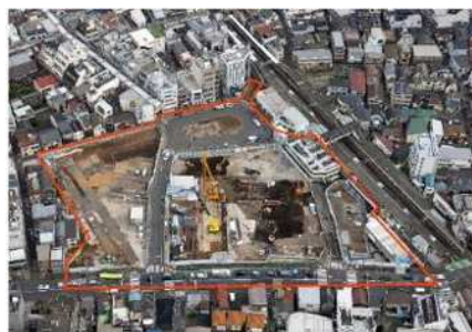
令和3年3月末（解体完了後）
