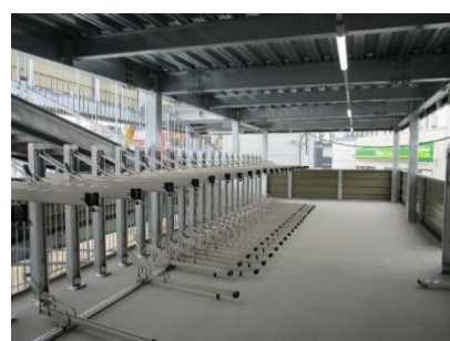
仮設自転車駐車場内部
