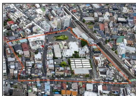
航空写真（解体工事開始前）
