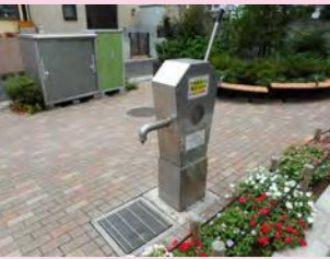
② 井戸ポンプ
