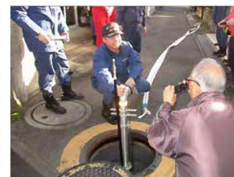
■吐水弁に設置したパイプに、ホースを取り付ける
