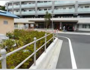
⑦ 外周パイプ柵
