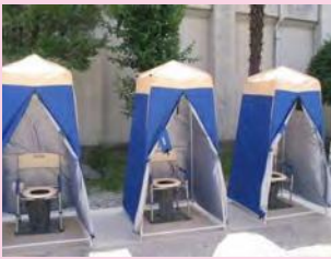
③ マンホールトイレ
