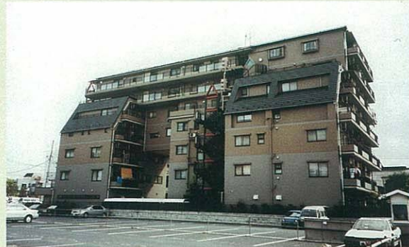
共同建て替えビル
