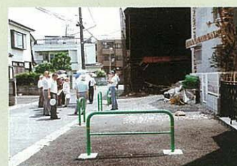
道路拡幅が進んでいます
