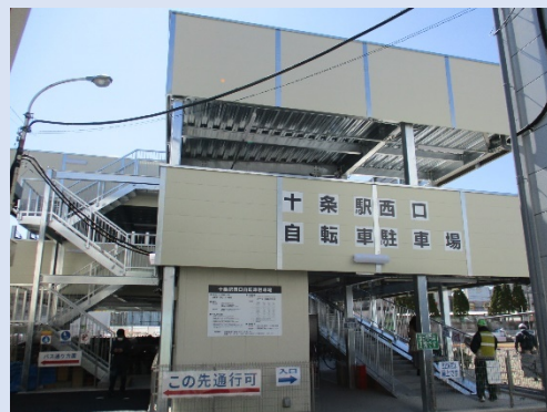
仮設自転車駐車場全景
