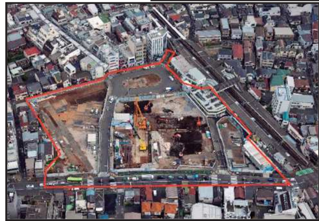
令和3年3月末(解体完了後)
