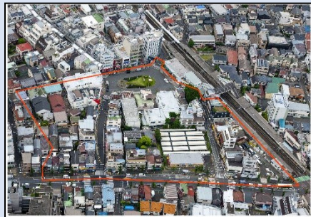
航空写真（解体工事開始前）
