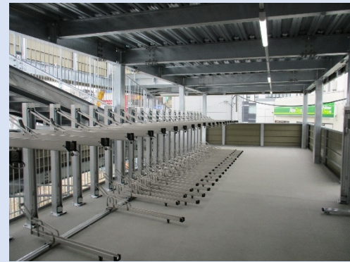
仮設自転車駐車場内部
