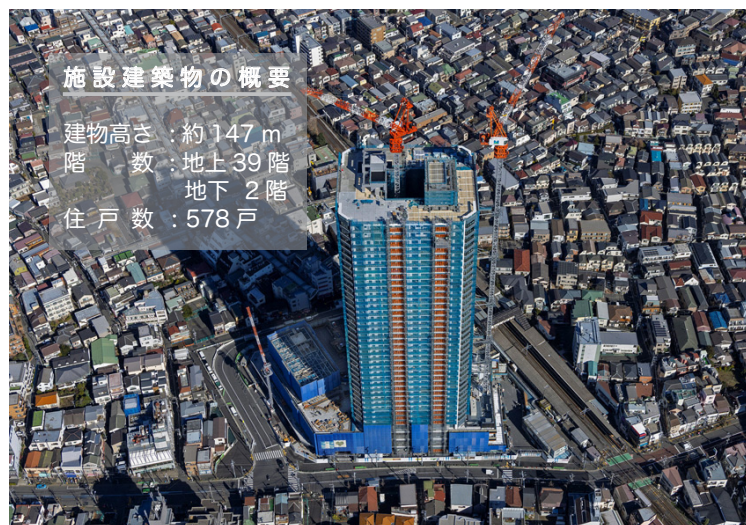
工事進捗写真（令和6年1月末時点）
