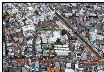
航空写真（解体工事開始前）
