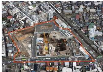
令和3年3月末（解体完了後）
