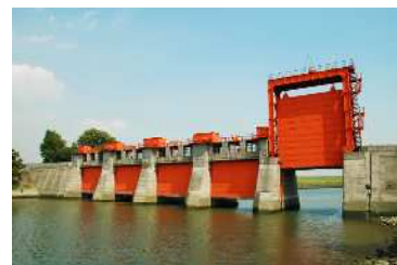
旧岩淵水門（赤水門）
