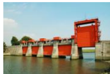
旧岩淵水門（赤水門）
