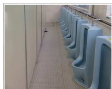
トイレ(改修前)
