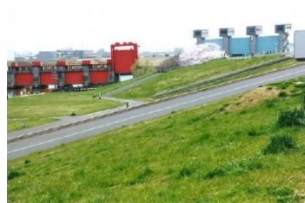
新旧岩淵水門（青水門・赤水門）
