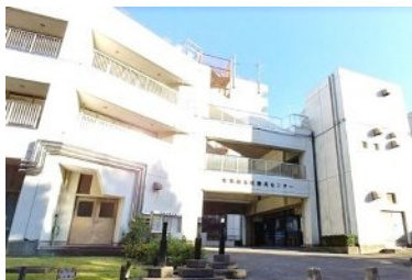
防災センター
