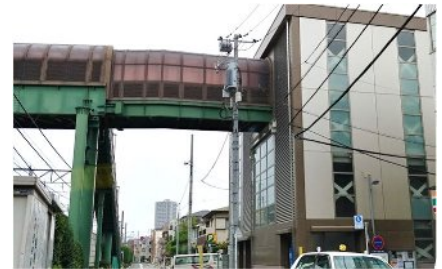
車坂跨線人道橋エレベーター
