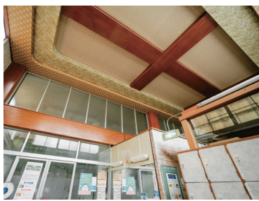
ビル型に建て替えても天井の高い開放的な脱衣場。
