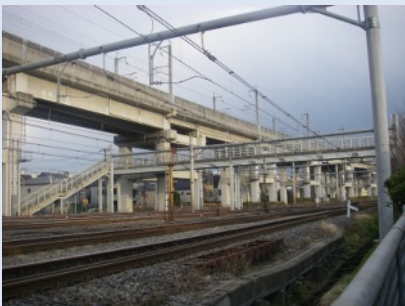
稻荷前跨線人道橋
