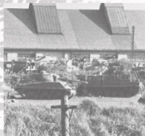
戦車修理工場として使用された赤羽西5丁目のTOD第2地区(放送局蔵氏撮影)
