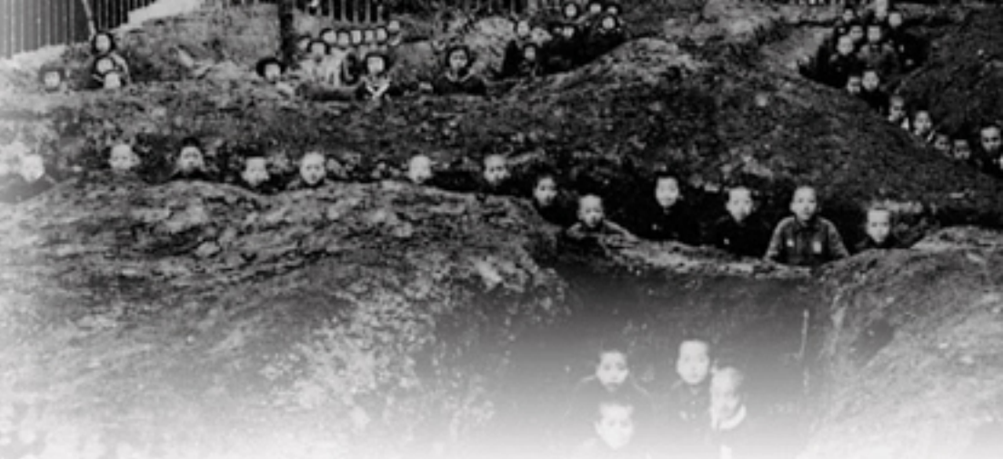
校庭に掘られた防空壕（滝野川第三国民学校昭和19年卒業アルバムより転載）
