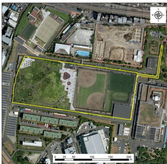
図 3.4.6 浮間水再生センター
