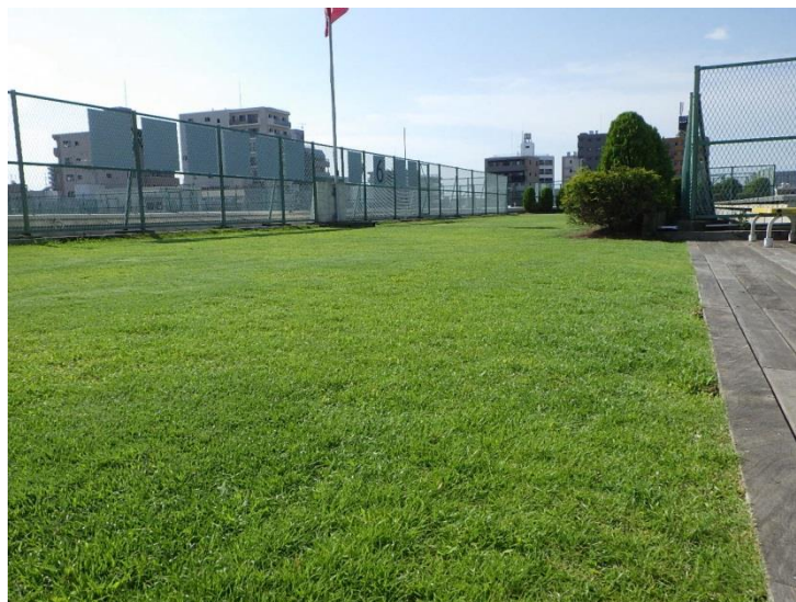
東十条小学校の屋上緑化
