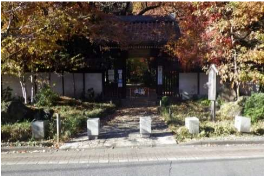
現況写真（薬医門前）
