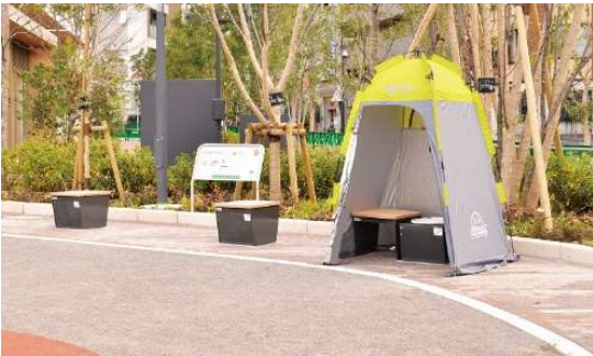
マンホールトイレ
