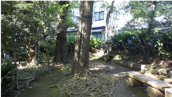
現況写真（舗装通路）
