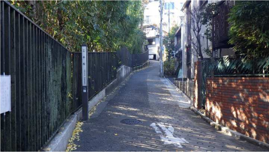
現況写真（三平坂 低地側より）
