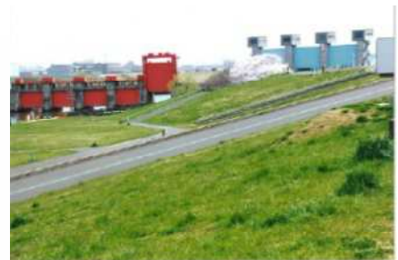
新旧岩淵水門（青水門・赤水門）
