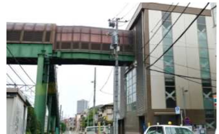
車坂跨線人道橋エレベーター
