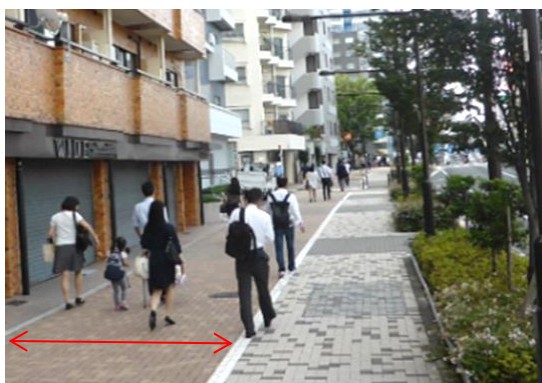
歩道有効幅員約3.5m
