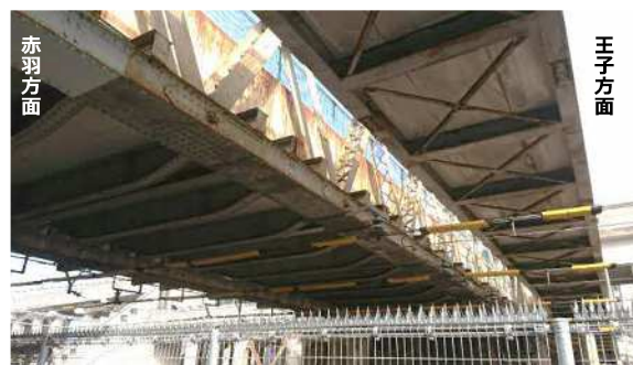
▲ 桁裏（右は後に新設された人道橋）
