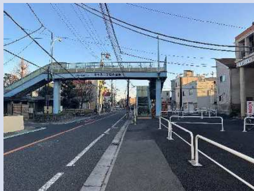
▲ 整備が進む補助第 83 号線
