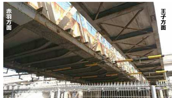
▲ 桁裏（右は後に新設された人道橋）
