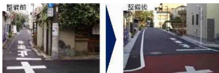
▲ 主要生活道路の整備例（道路拡幅・無電柱化）
