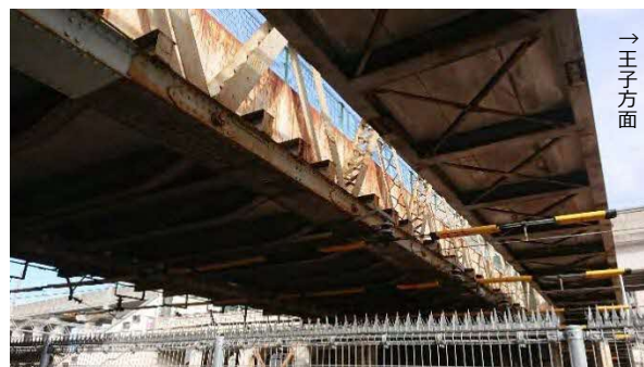
▲ 桁裏 (右は後に新設された人道橋)
