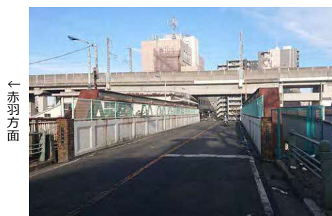
▲ 現在の十条跨線橋
