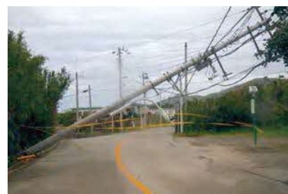
▲ 新島若郷地区の被害状況（令和元年 9 月）
