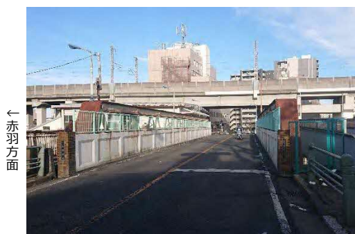
▲ 現在の十条跨線橋
