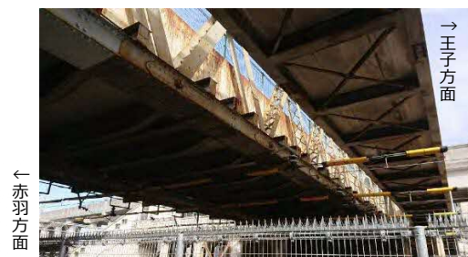
▲ 桁裏（右は後に新設された人道橋）
