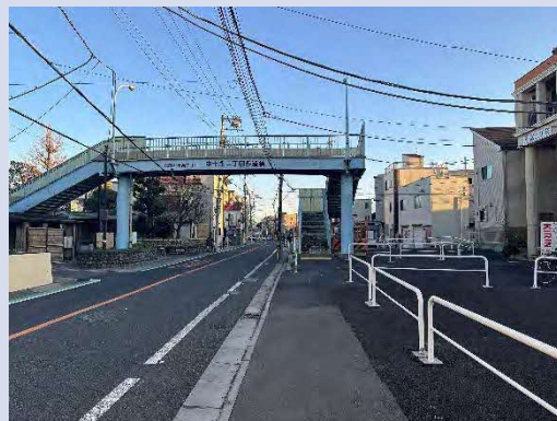
▲ 整備が進む補助第 83 号線
