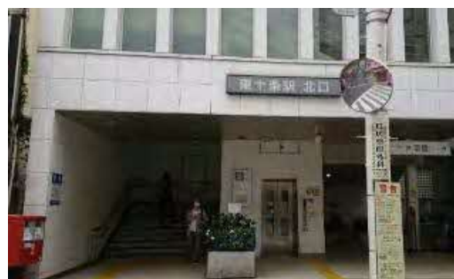
▲ 東十条駅北口のエレベーター
