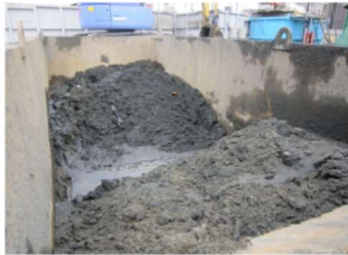
回収した堆積土
