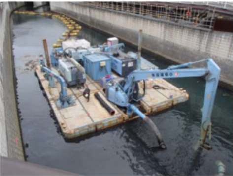
河床の堆積土を引き上げる状況
