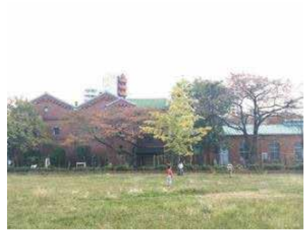
旧醸造試験所第一工場
