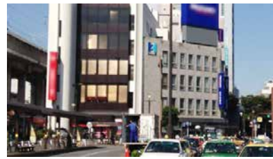
駅北口の業務施設
