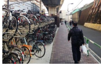
駐輪場・JR線路擁壁
