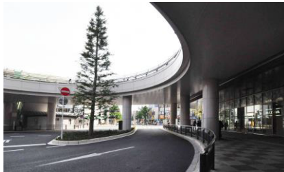
八王子駅南口駅前広場（八王子市）
