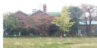
旧醸造試験所第一工場
