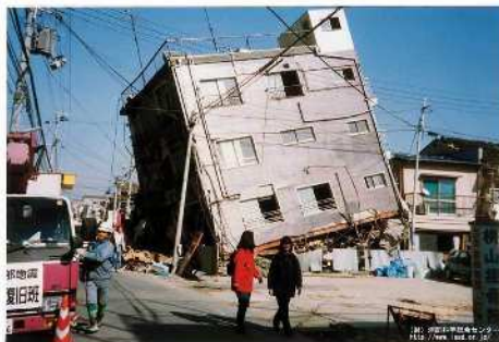
写真：道路を閉鎖した建築物（阪神・淡路大震災） （出典：災害写真データベース）
