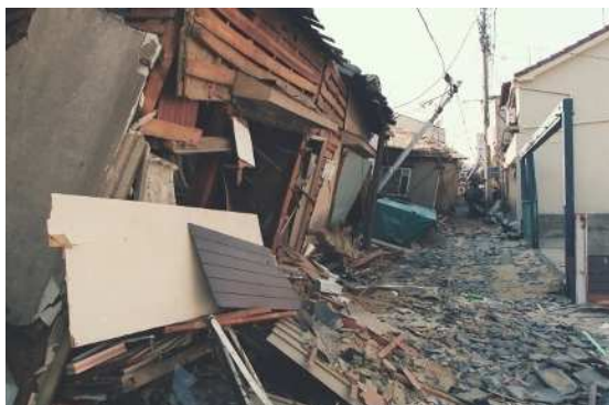
写真：阪神・淡路大震災で倒壊した木造建築物 (出典：震災写真オープンデータサイト 「阪神・淡路大震災『1.17の記録』」)
