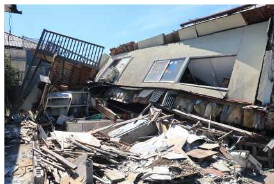
写真：熊本地震で倒壊した建築物 (出典：熊本災害デジタルアーカイブ ／提供者：富士マイクロ株式会社)
