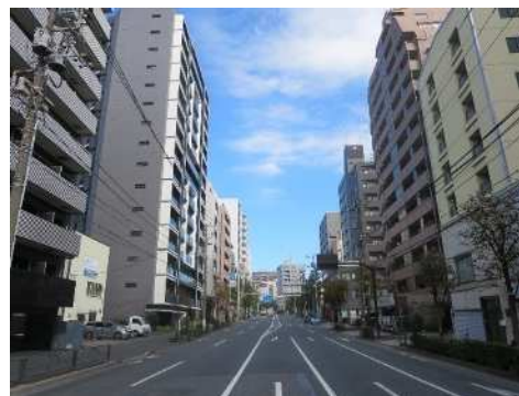
写真：一般緊急輸送道路 (明治通り 滝野川7丁目付近)
