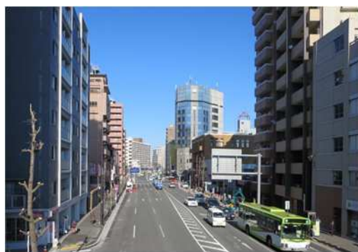
写真：特定緊急輸送道路 (北本通り 王子4丁目付近)
