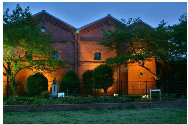
【旧醸造試験所第一工場】
