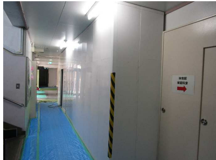
【仮設間仕切り】
