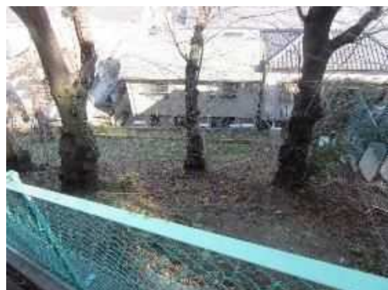
⑫崖地（階段上から）
