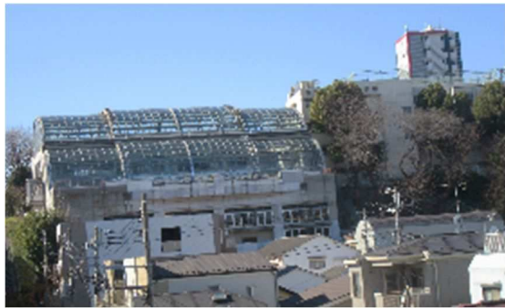
⑤体育館棟全景（1／2）
