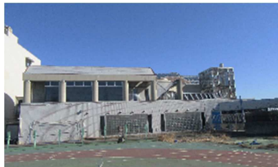
⑥体育館棟全景（2／2）
