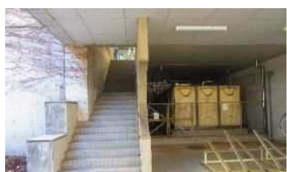
⑩体育館棟階段（2／2）
