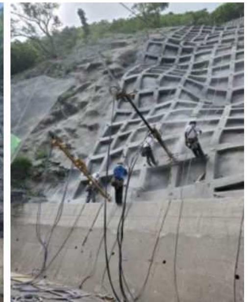
②法枠吹付・鉄筋挿入工 （モルタル吹付）
