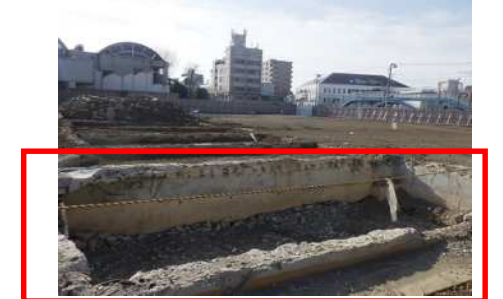
地中梁 (旧校舎基礎)
