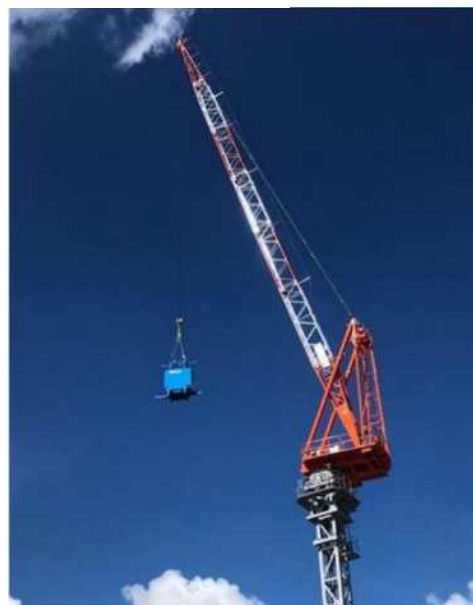
タワークレーン
