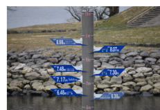
令和元年東日本台風 岩瀬水門(上)水位観測所で戦後3番目に高い水位に
