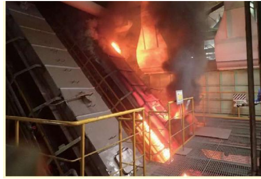
中防処理施設での火災(清掃一組)
